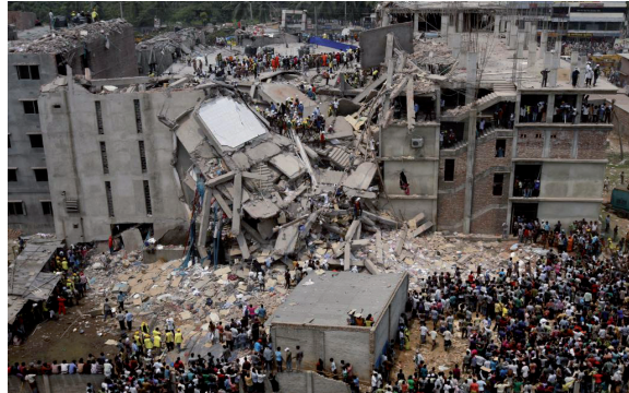
De ingestorte fabriek op Rana Plaza, in de hoofdstad Dhaka
