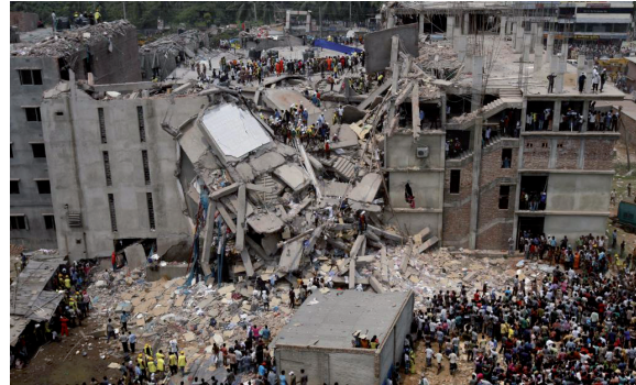
Ingestorte kledingfabriek in Dhaka (24 april, 2013)
