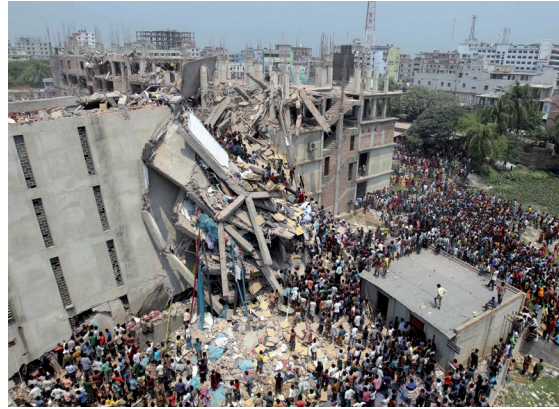
Ingestorte kledingfabriek in Dhaka (24 april, 2013)
